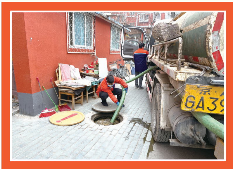
社区联系城市管理办公室协调应急抢修队对污水井进行清掏
